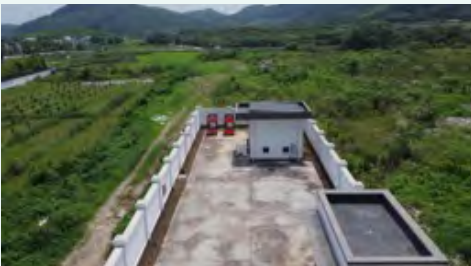
燃气微管网项目设施
